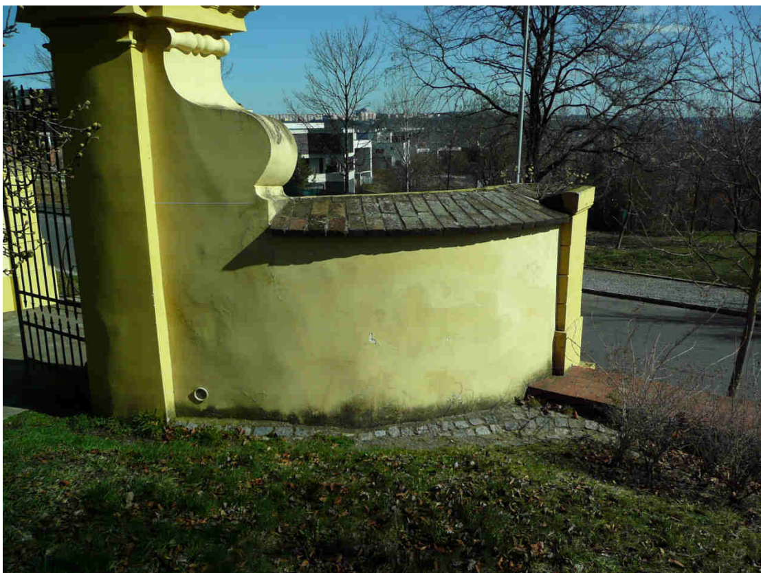
STŘEDNÍ ČÁST S BRÁNOU – koruna zdí zakrytá cihlami na plocho
