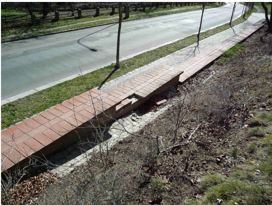
JIŽNÍ OPĚRNÁ ZEĎ – koruna krytá cihlami „na plocho“, spádování do odvodňovacího žlabu za zdí
