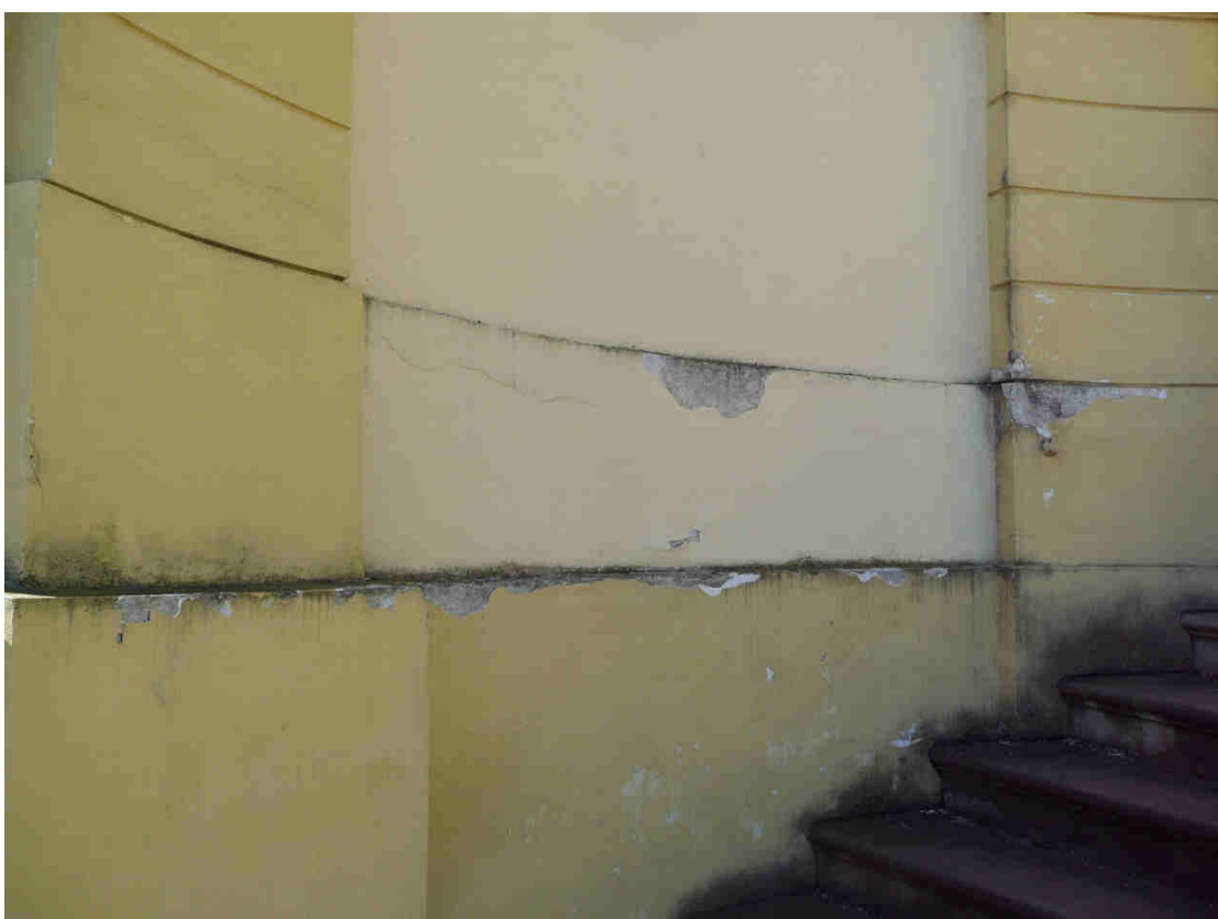
STŘEDNÍ ČÁST S BRÁNOU – lokální poškození omítek zatečením
