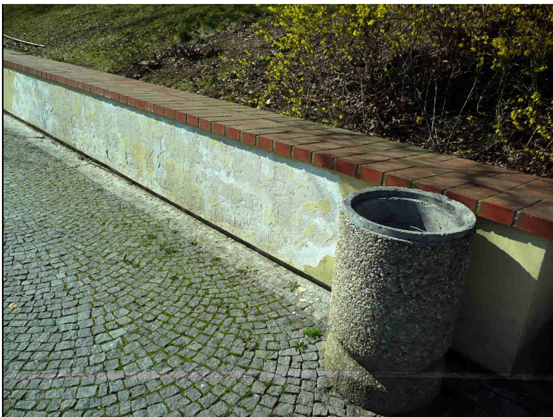
SEVERNÍ OPĚRNÁ ZEĎ – poškození omítek vlhkostí
