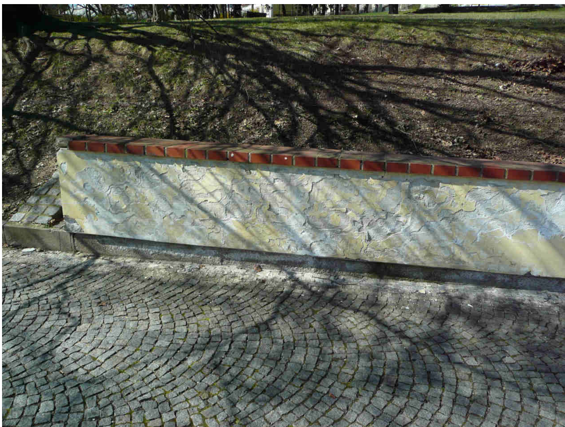
JIŽNÍ OPĚRNÁ ZEĎ – jižní okraj zdi s vyústěním odvodňovacího žlabu Celoplošné poškození omítaných povrchů
