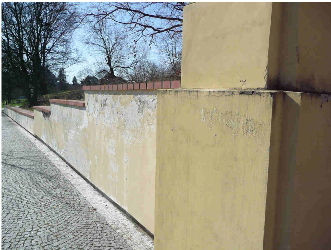
JIŽNÍ OPĚRNÁ ZEĎ – napojení na střední část s bránou. Poškození omítek celoplošné, nejvýraznější v pásu cca 40 – 50 cm pod korunou zdi – příčinou pravděpodobně zatékání do koruny zdi
