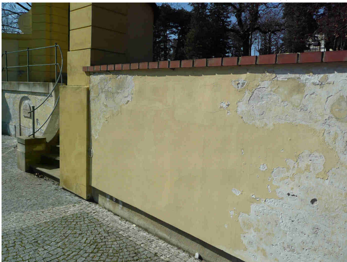
SEVERNÍ OPĚRNÁ ZEDĚ – nevhodné napojení na střední část s bránou:
