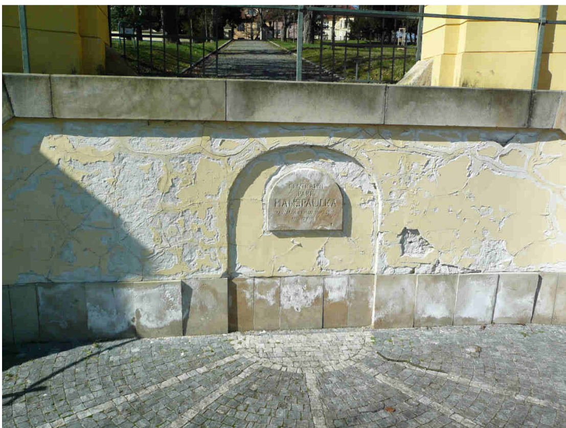
STŘEDNÍ ČÁST S BRÁNOU – čelní stěna předsazeného schodiště Celoplošné poškození omítaného povrchu a soklového obkladu vlhkostí a solemi
