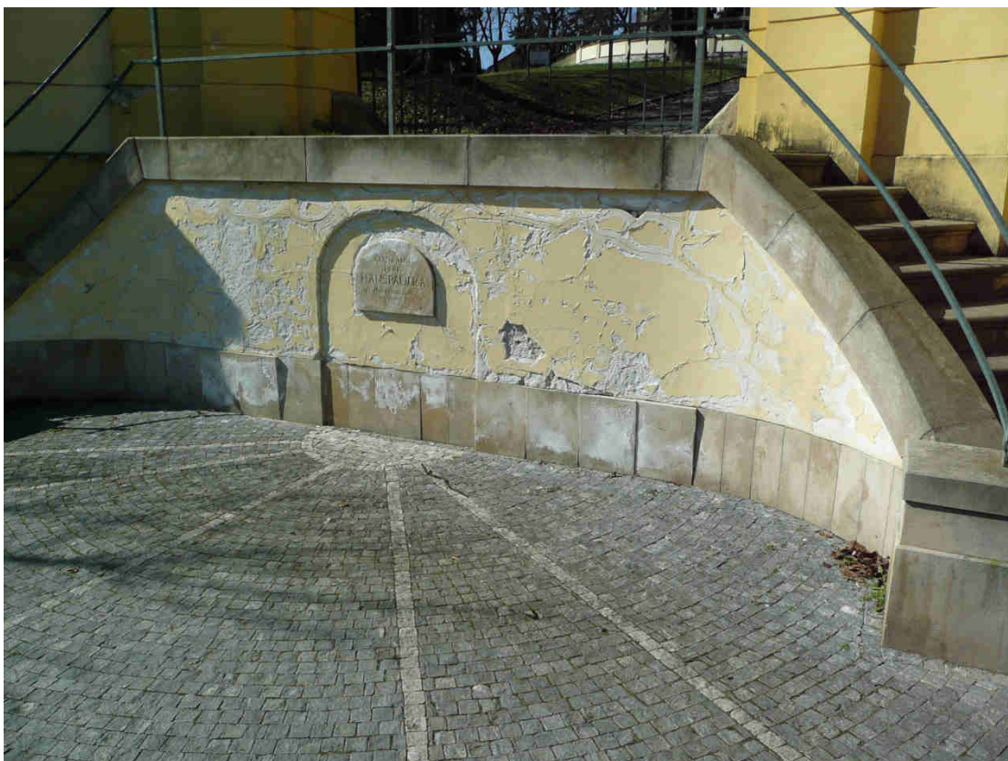
STŘEDNÍ ČÁST S BRÁNOU – čelní stěna předsazeného schodiště Celoplošné poškození omítaného povrchu a soklového obkladu vlhkostí a solemi
