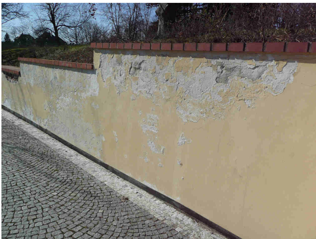
JIŽNÍ OPĚRNÁ ZEĎ – poškození omítek vlhkostí a solemi
