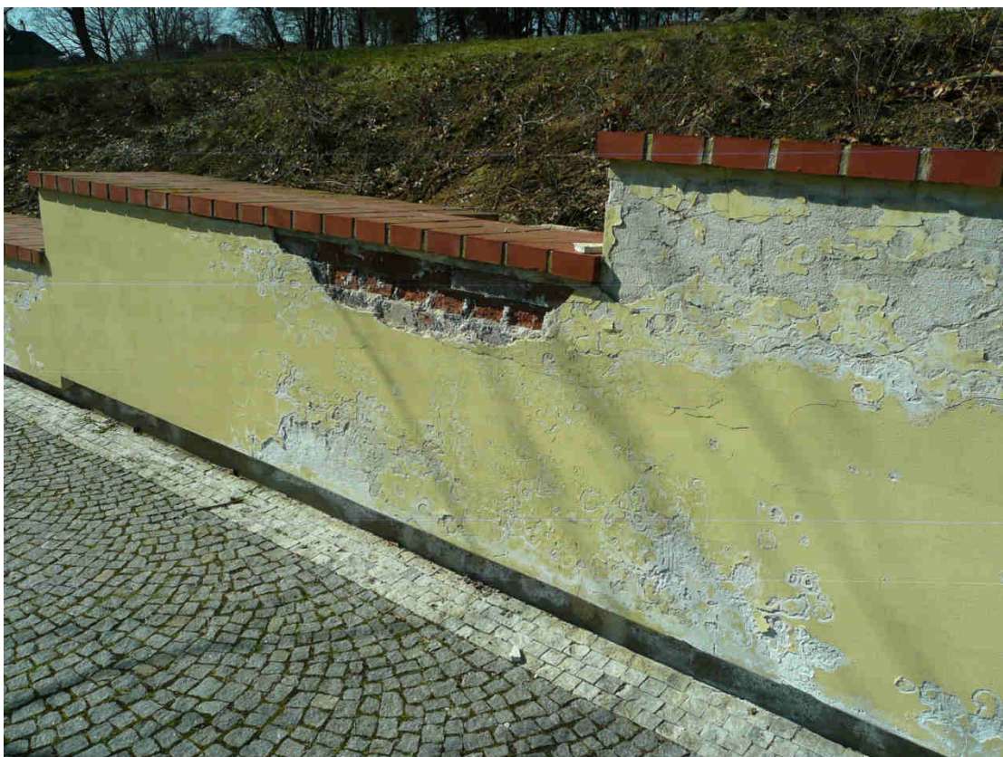
JIŽNÍ OPĚRNÁ ZEĎ – poškození omítek vlhkostí, pod korunou poškození zdiva odmrznutím (příčinou pravděpodobně zatékání do koruny zdi)
