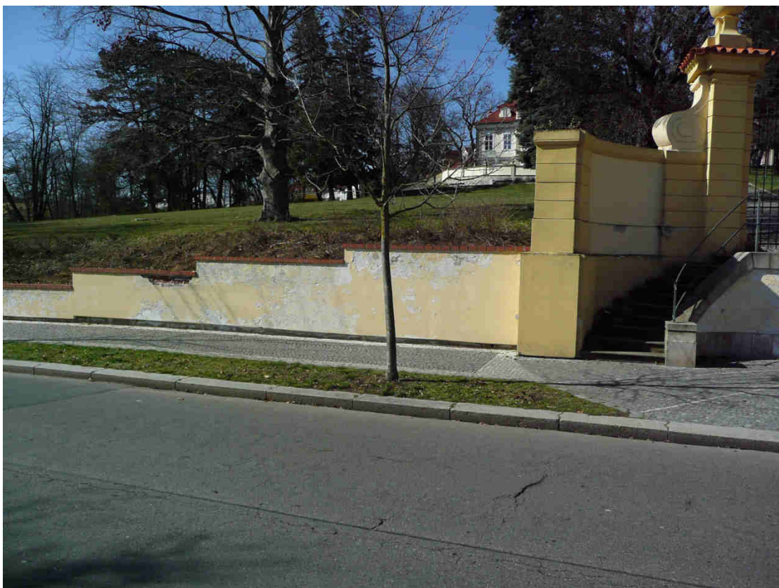
JIŽNÍ OPĚRNÁ ZEĎ – napojení na střední část s bránou. Poškození omítek prakticky celoplošné, nejvýraznější v místě odkapávání vody z přesahující koruny zdi (cca 40 – 50 cm pod korunou zdi)
