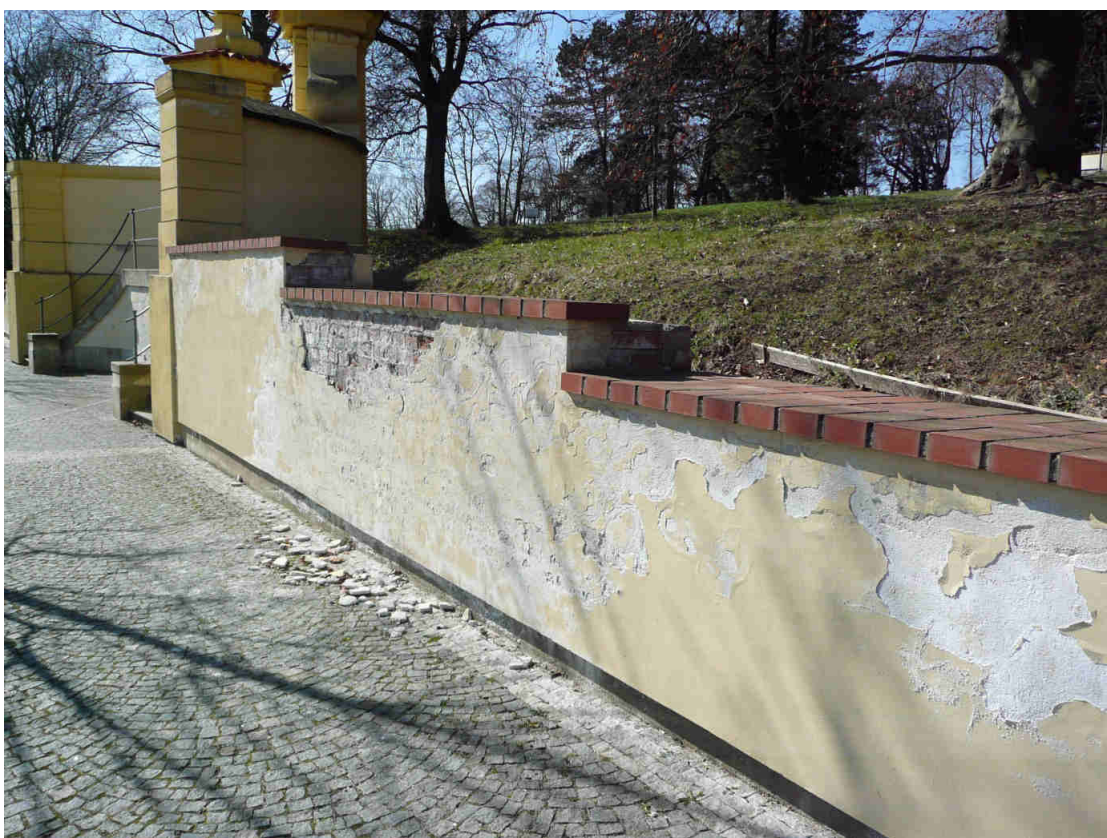
SEVERNÍ OPĚRNÁ ZEĎ – poškození omítek vlhkostí, pod korunou poškození zdiva odmrznutím (příčinou pravděpodobně zatékání do koruny zdi)
