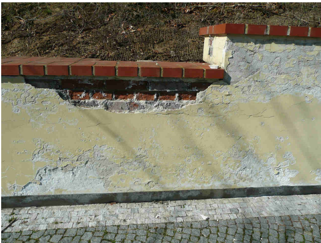
JIŽNÍ OPĚRNÁ ZEĎ – poškození omítek vlhkostí, pod korunou poškození zdiva odmrznutím (příčinou pravděpodobně zatékání do koruny zdi)
